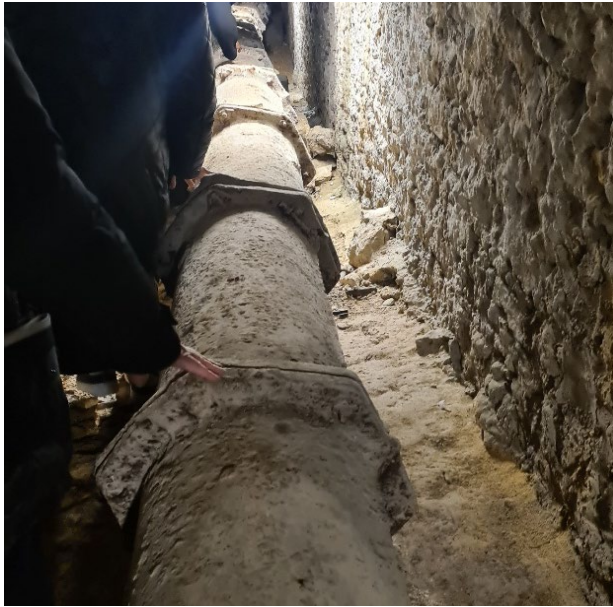
Abbildung 2-1: In Betrieb befindliche geflanschte Grauguss-Rohre der Brunnenanlage von Schloss Versailles (ca. 1680) (eigene Aufnahme Bennerscheidt)
