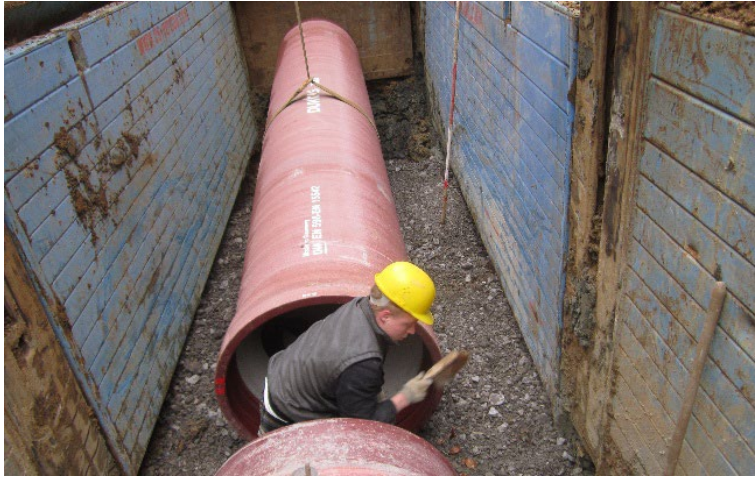
Abbildung 2-4: Einbau eines duktilen Gussrohres nach EN 598 mit einer Zementmörtel-Umhüllung nach EN 15542 (Martin und Rink, 2014)
